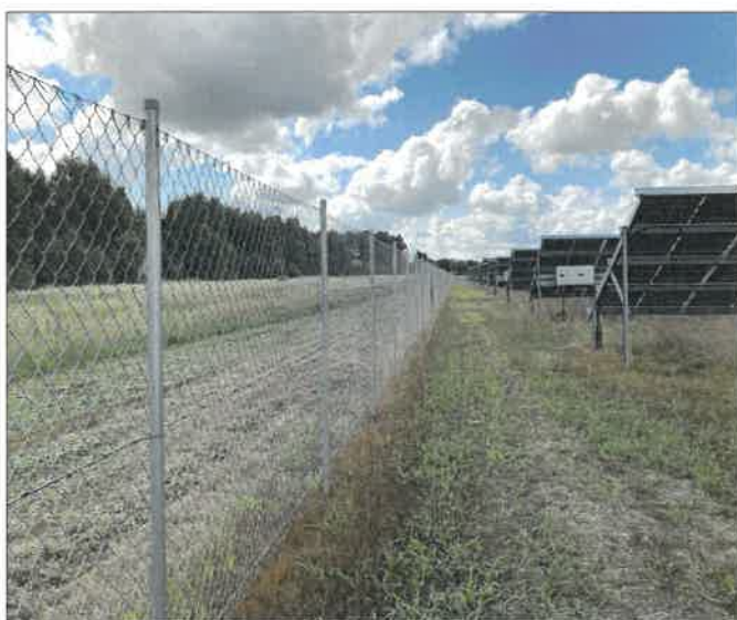
Zdjęcie 10 Ogrodzenie terenu inwestycji
