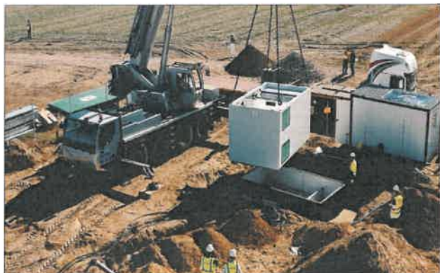
Zdjęcie 7 Stacja transformatorowa - montaż
