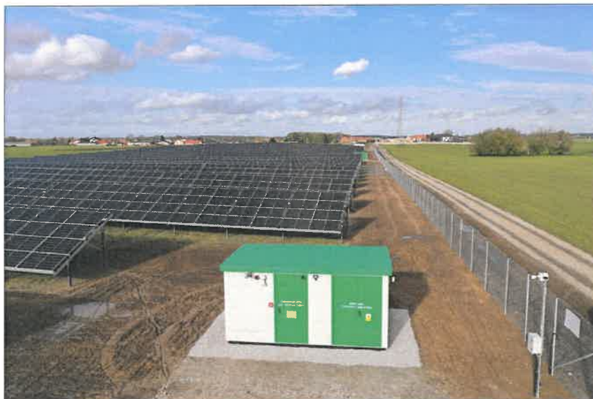
Zdjęcie 12 Plac pod stacją trafo.
