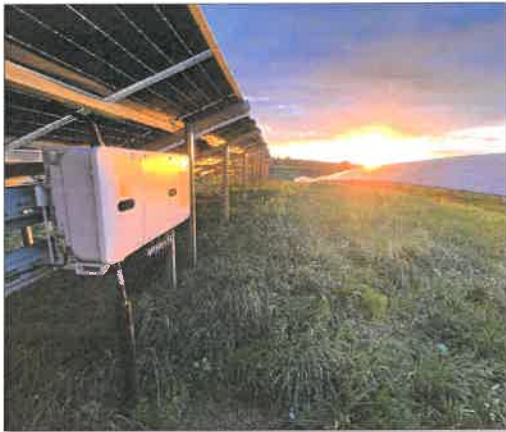
Zdjęcie 5 Inwerter – montaż na konstrukcji
