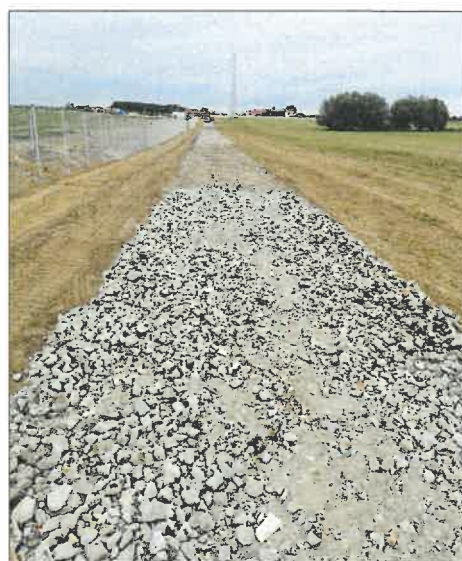
Zdjęcie 11 Droga wewnętrzna
