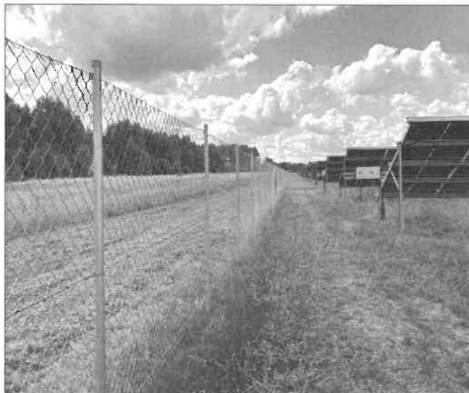
Zdjęcie 10 Ogrodzenie terenu inwestycji
