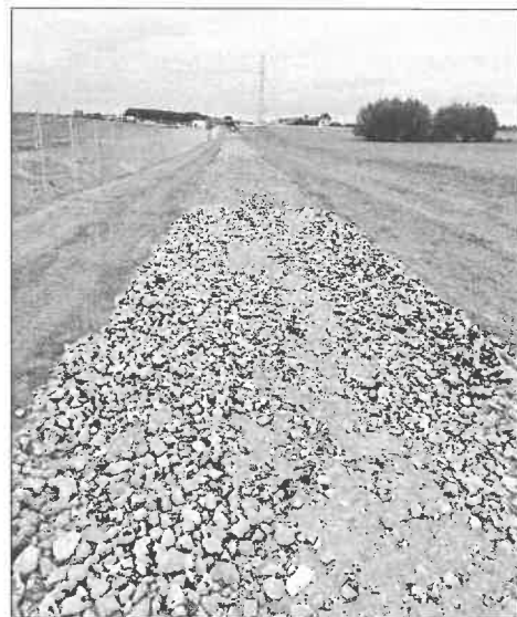
Zdjęcie 11 Droga wewnętrzna
