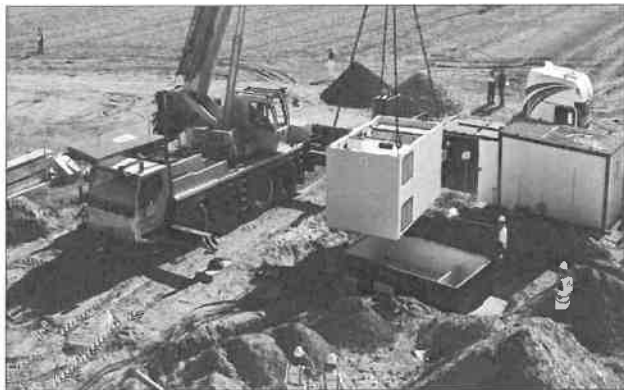
Zdjęcie 7 Stacja transformatorowa - montaż
