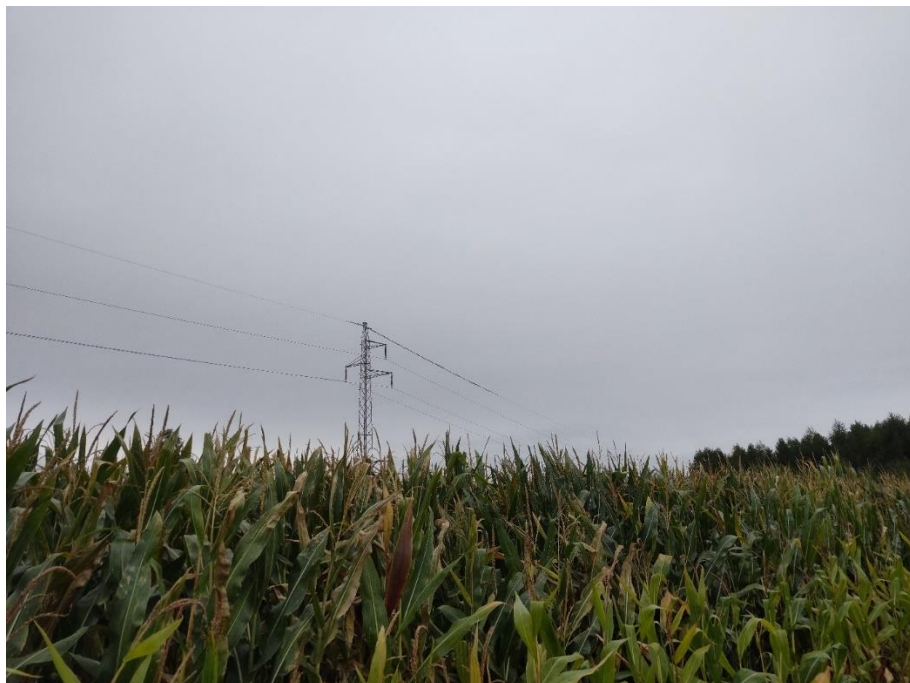
Zdjęcie 7 Linie wysokiego napięcia
