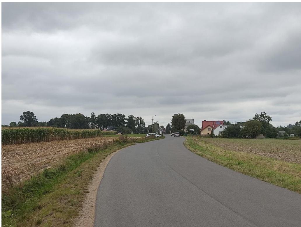
Zdjęcie 8 Utwardzona droga, budynki mieszkalne i gospodarcze
