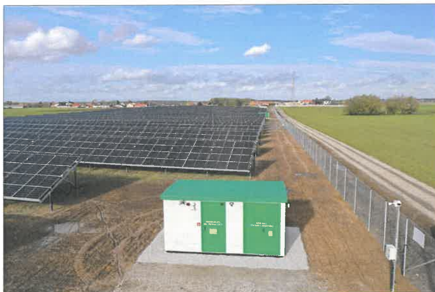
Zdjęcie 12 Plac pod stacją trafo.
