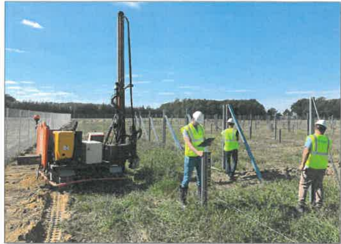
Zdjęcie 4 Montaż konstrukcji wsporczej
