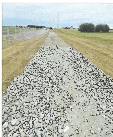
Zdjęcie 11 Droga wewnętrzna
