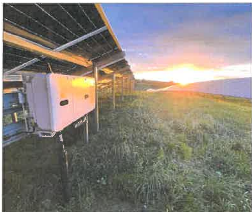
Zdjęcie 5 Inwerter – montaż na konstrukcji
