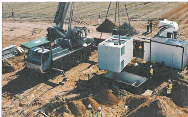
Zdjęcie 7 Stacja transformatorowa - montaż
