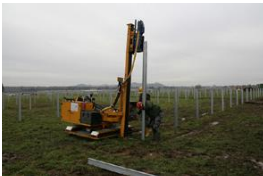
Zdjęcie 2. Montaż profili za pomocą kafara.
