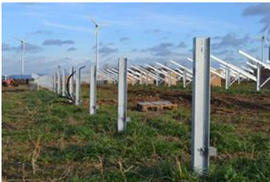
Zdjęcie 1. Profile metalowe: podstawowy element konstrukcji.
