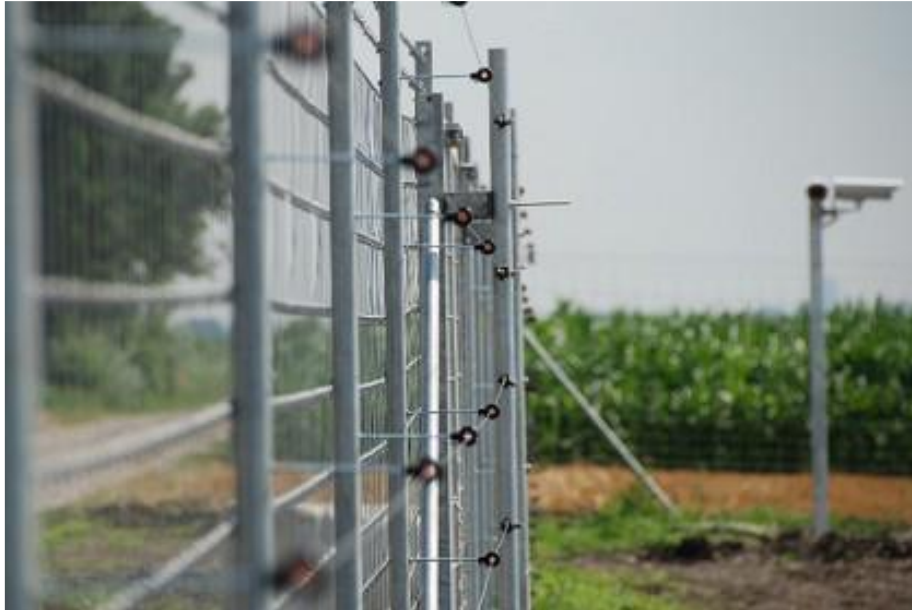
Rysunek 3. Przykładowe ogrodzenie farmy fotowoltaicznej.
