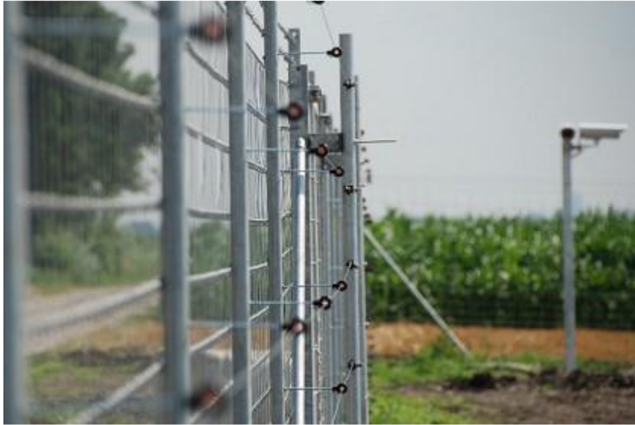
Rysunek 3. Przykładowe ogrodzenie farmy fotowoltaicznej.
