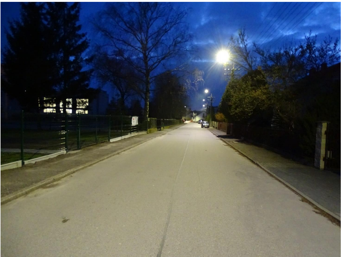
Fot. Zmodernizowane oświetlenie uliczne – ul. Szkolna w Świerczach
