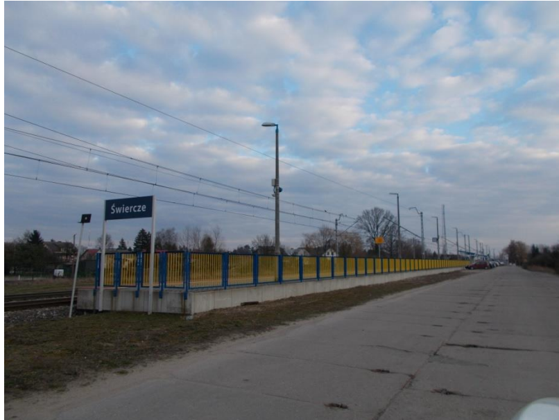
Fot. 1 Linia kolejowa E-65 (tereny zamknięte)
