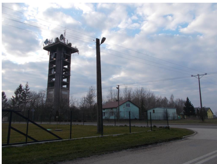
Fot. 4 ul. Pułtуска żelbetowa wieża Emitel
