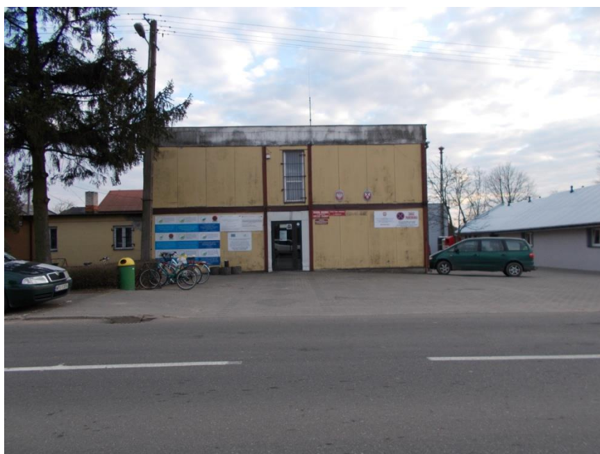
Fot. 8 – Budynek Urzędu Gminy
