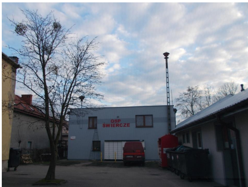
Fot. 9 – Budynek OSP
