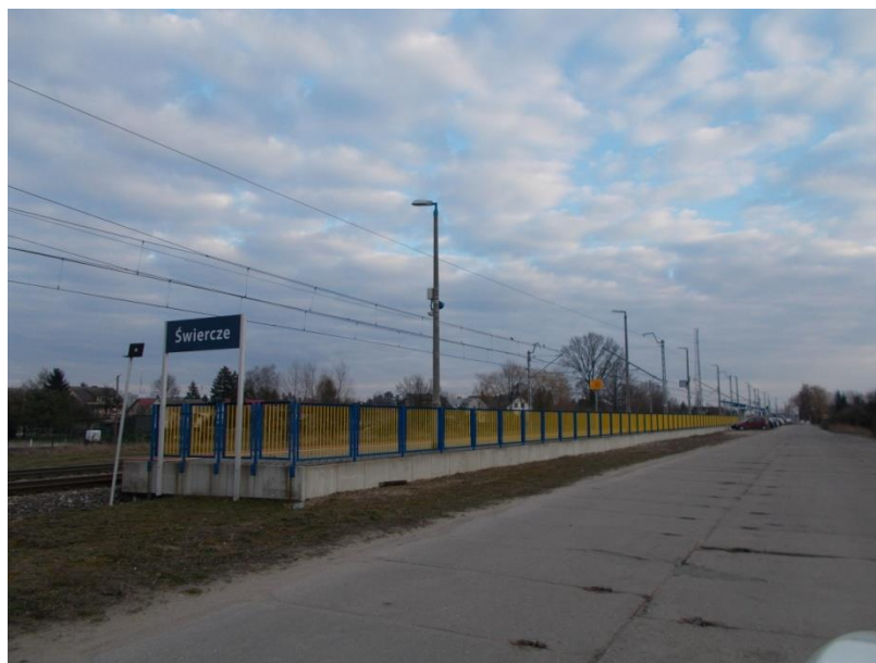
Fot. 1 Linia kolejowa E-65 (tereny zamknięte)
