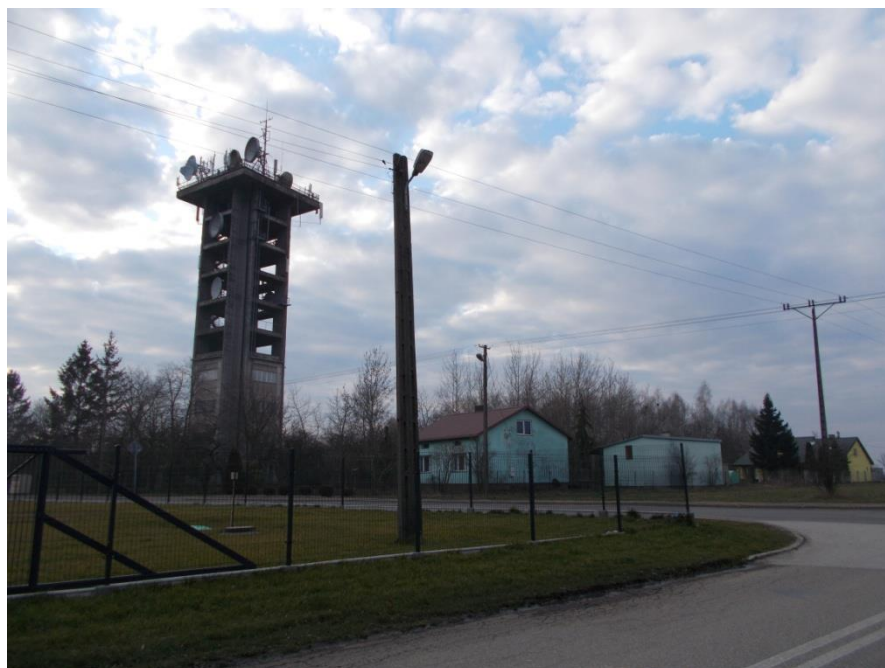
Fot. 4 ul. Pułtуска żelbetowa wieża Emitel
