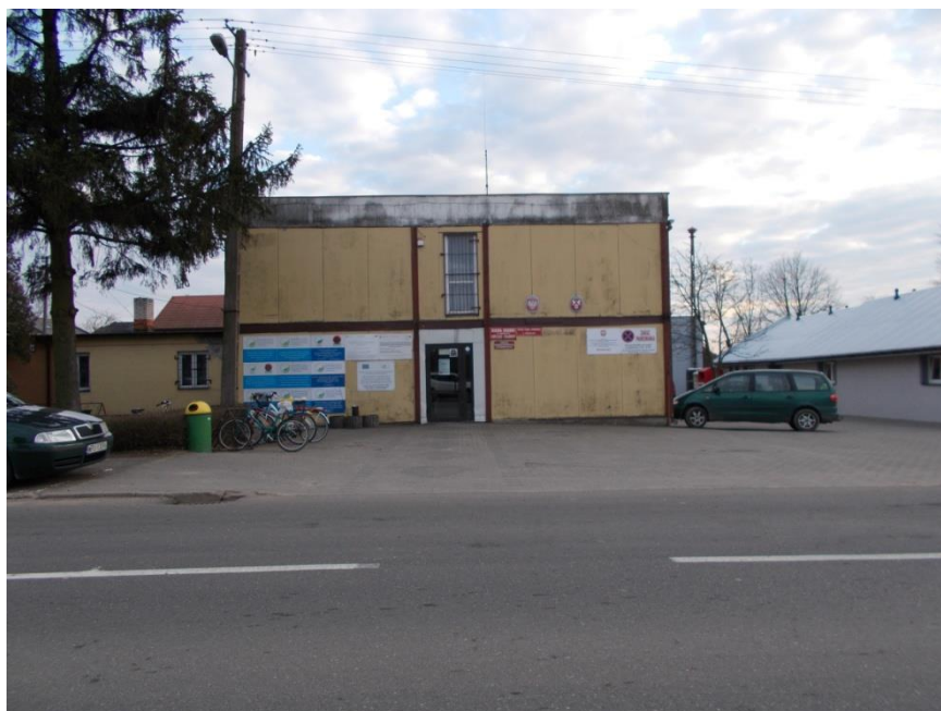
Fot. 8 – Budynek Urzędu Gminy
