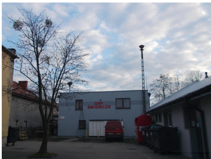
Fot. 9 – Budynek OSP
