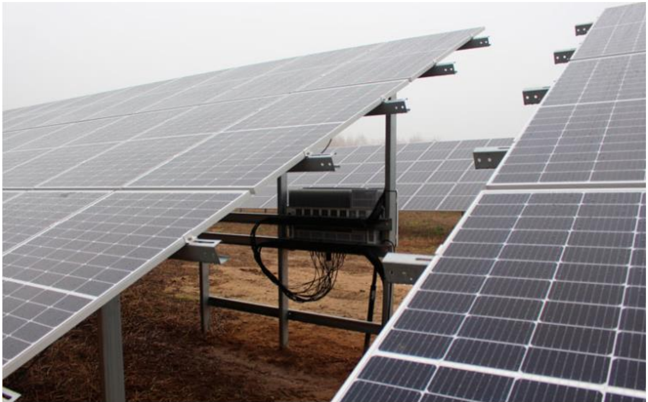
Rysunek 9: Sposób montażu paneli fotowoltaicznych na stelażach wbijanych bezpośrednio do gruntu (źródło: https://www.rynekelektryczny.pl/farmy-fotowoltaiczne-w-grupie-tauron/ )
