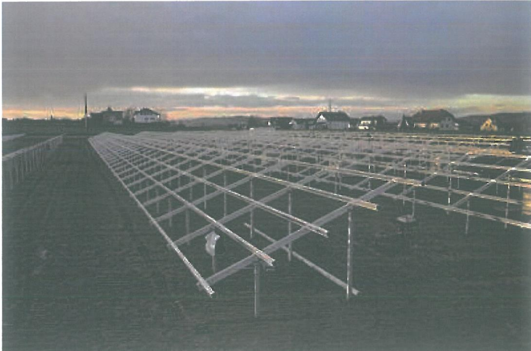
Rysunek 12: Szkielety przed montażem paneli, źródło: farma solarna NIENBURG 4 MW, Niemcy, Remor Solar.
