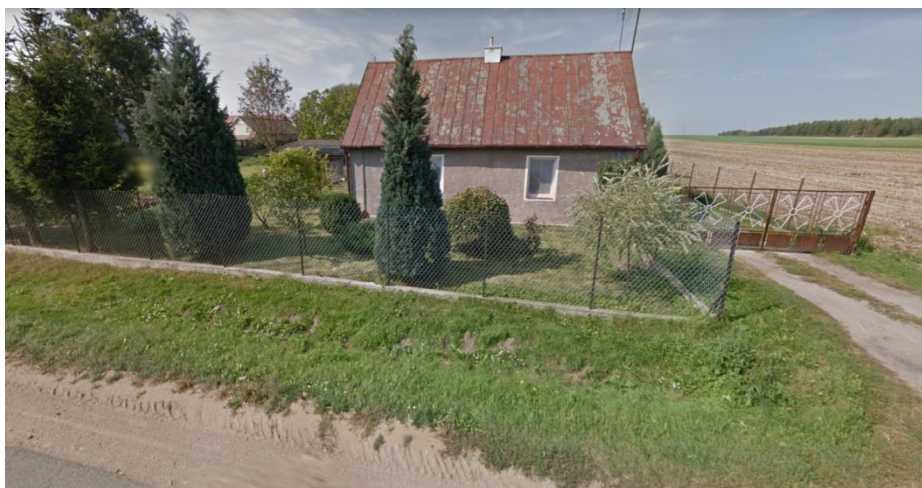
Fot. 3 Niska zabudowa mieszkaniowa - widok z drogi powiatowej
