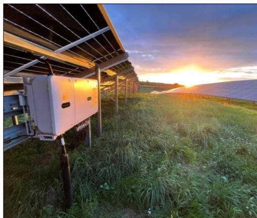
Zdjęcie 5 Inwerter – montaż na konstrukcji
