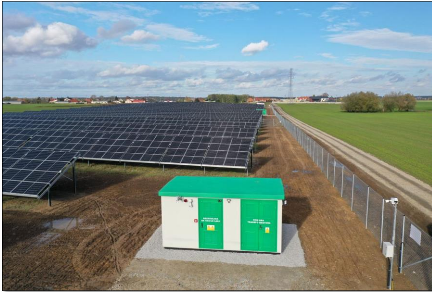
Zdjęcie 15 Plac pod stacją trafo.
