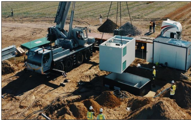
Zdjęcie 10 Stacja transformatorowa - montaż
