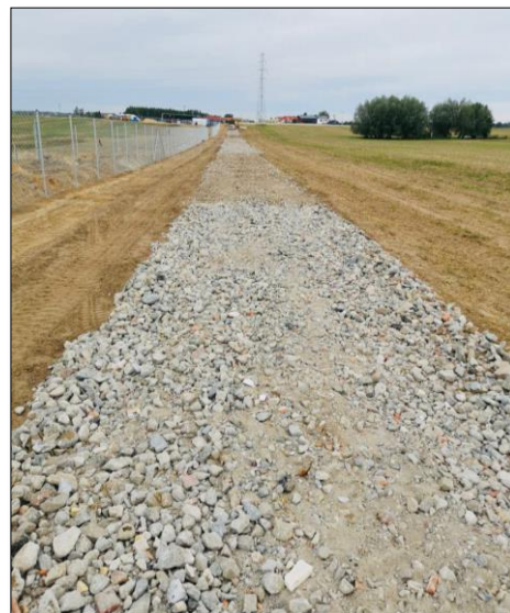
Zdjęcie 14 Droga wewnętrzna
