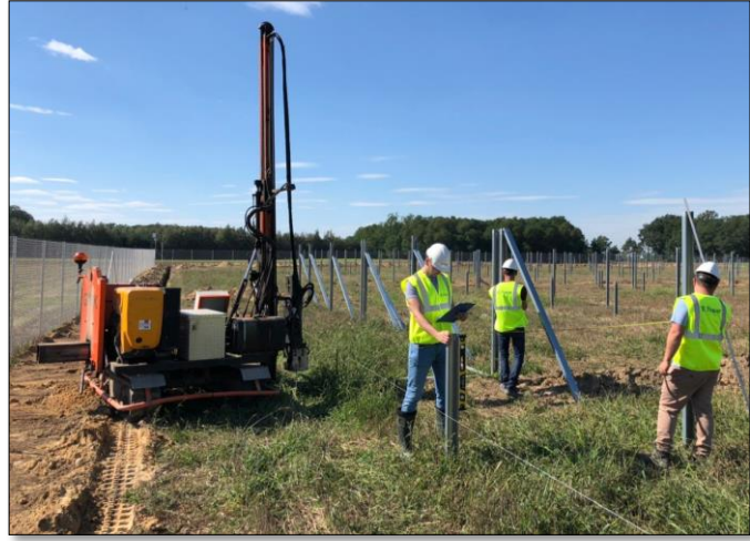
Zdjęcie 4 Montaż konstrukcji wsporczej
