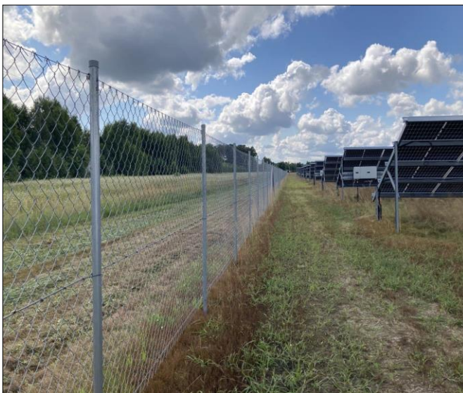
Zdjęcie 13 Ogrodzenie terenu inwestycji
