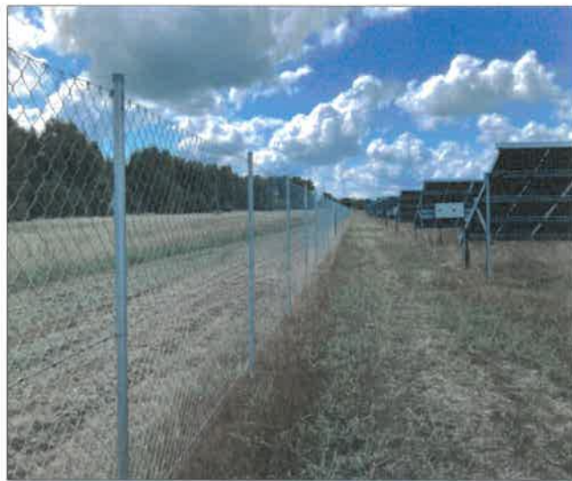
Zdjęcie 13 Ogrodzenie terenu inwestycji
