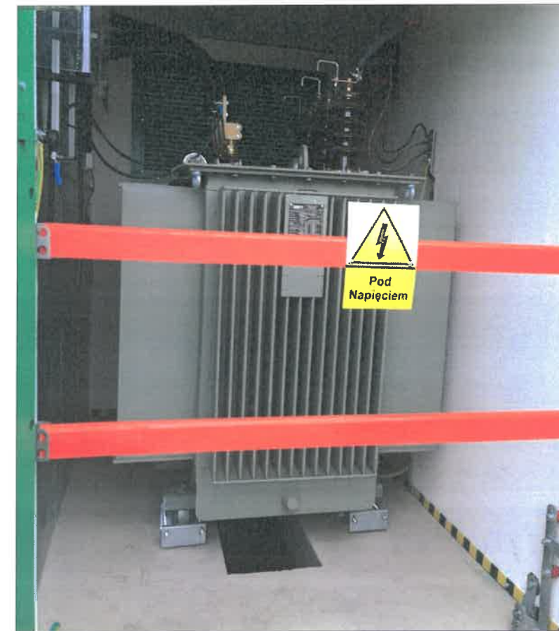
Zdjęcie 8 Otwór w posadzce
