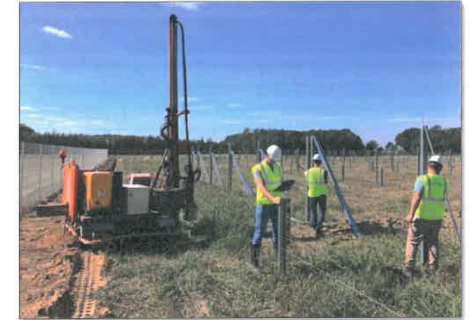
Zdjęcie 4 Montaż konstrukcji wsporczej
