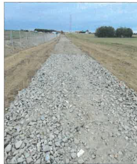
Zdjęcie 14 Droga wewnętrzna
