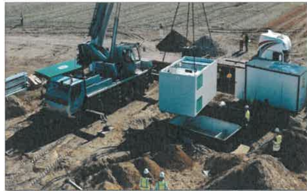
Zdjęcie 10 Stacja transformatorowa - montaż
