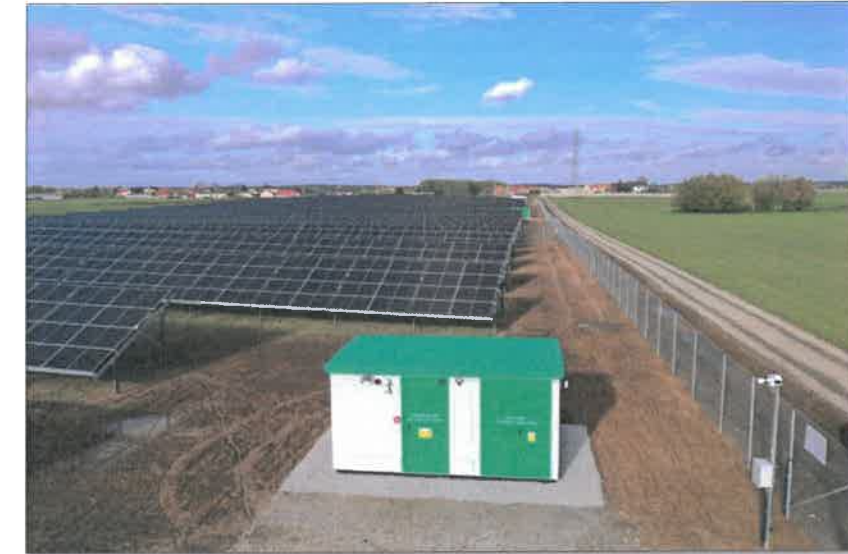
Zdjęcie 15 Plac pod stacją trafo.
