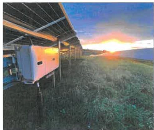
Zdjęcie 5 Inwerter – montaż na konstrukcji
